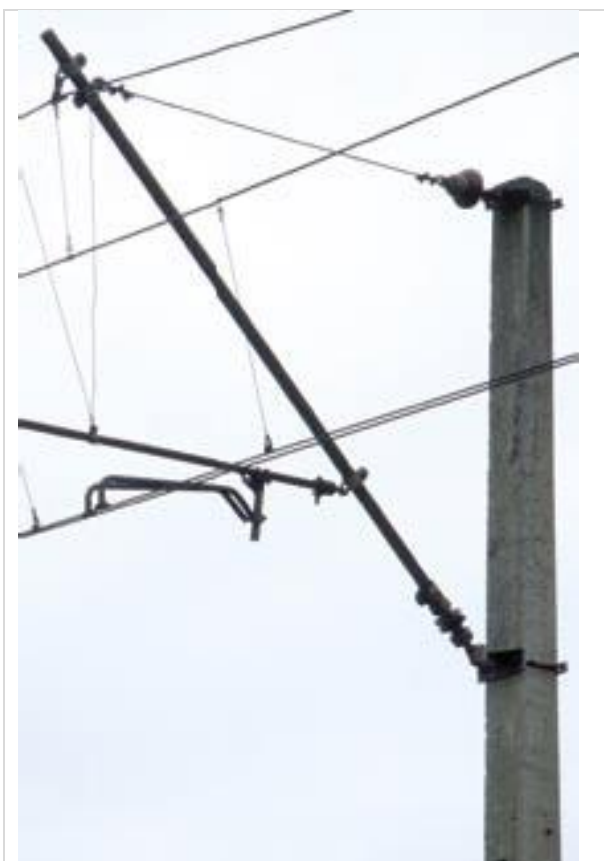
61.attēls Putniem bīstams vadu stiprinājums pie staba, kāds vēl arvien plaši tiek izmantots Austrumeiropā: staba gals ir atdalīts no vadiem zem sprieguma tikai ar ļoti īsu izolatoru (NABU 2006).
