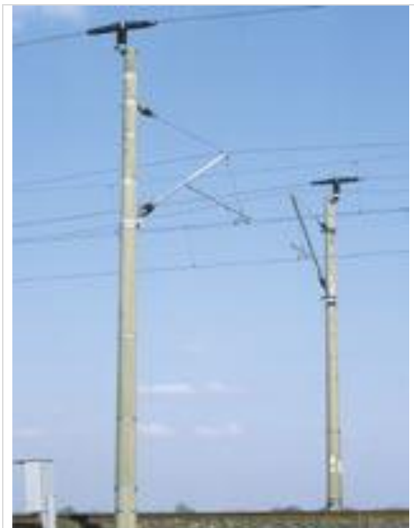
60. attēls. Dzelzceļa elektrolīnijas stabi Vācijā, kas ir iecienīta, bet bīstama putnu sēdēšanas vieta, jo vads, kas ir zem sprieguma, piestiprināts staba galam. Lai samazinātu risku putniem vadi nosegti ar 130 cm garu izolējošu materiālu (NABU 2006).
