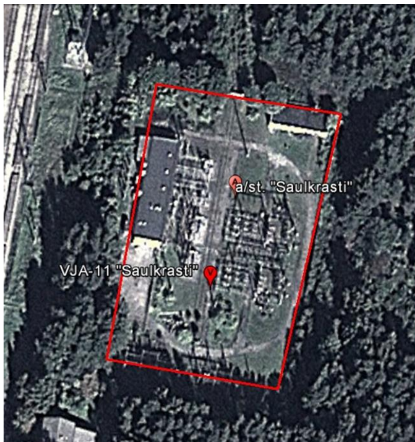
48.attēls VJA-11 Saulkrasti pieslēgums pie elektrotīkla
