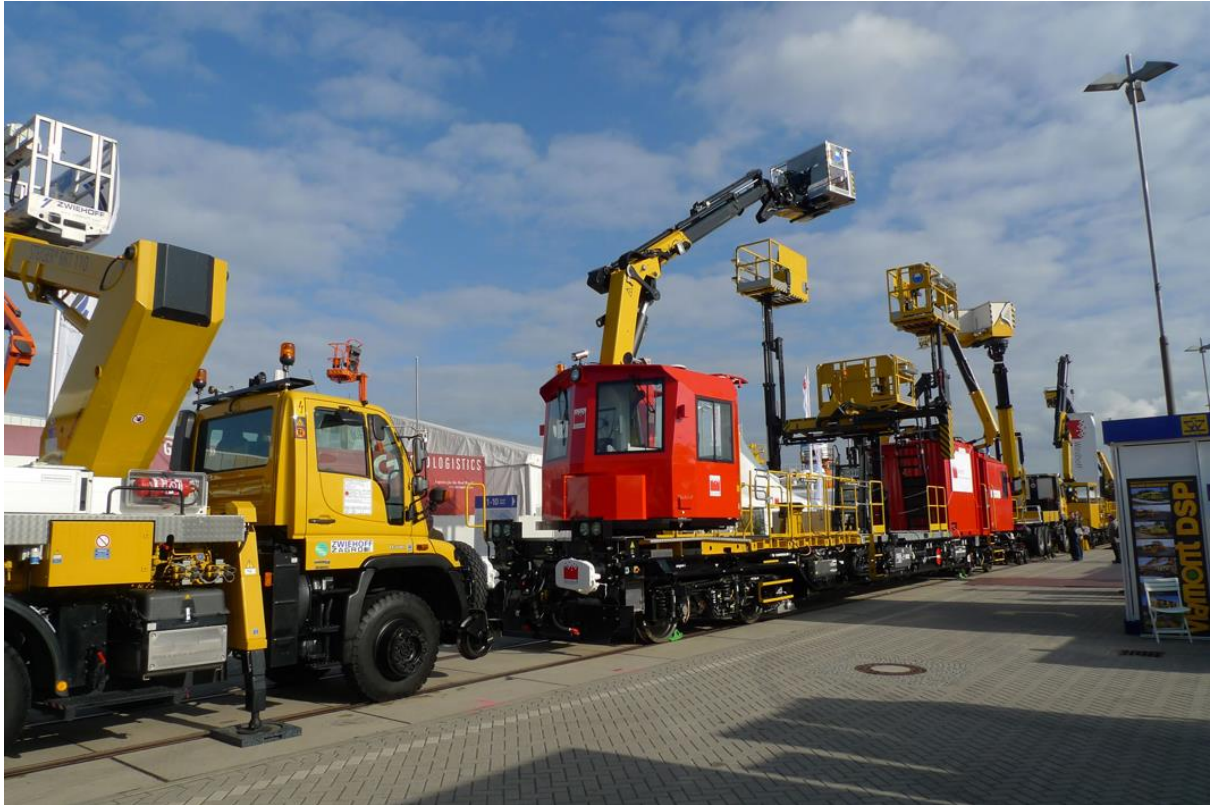
55.attēls Būvniecības vilciens un tehnika darbam staciju un pārbrauktuvju teritorijās. Avots: LDZ
