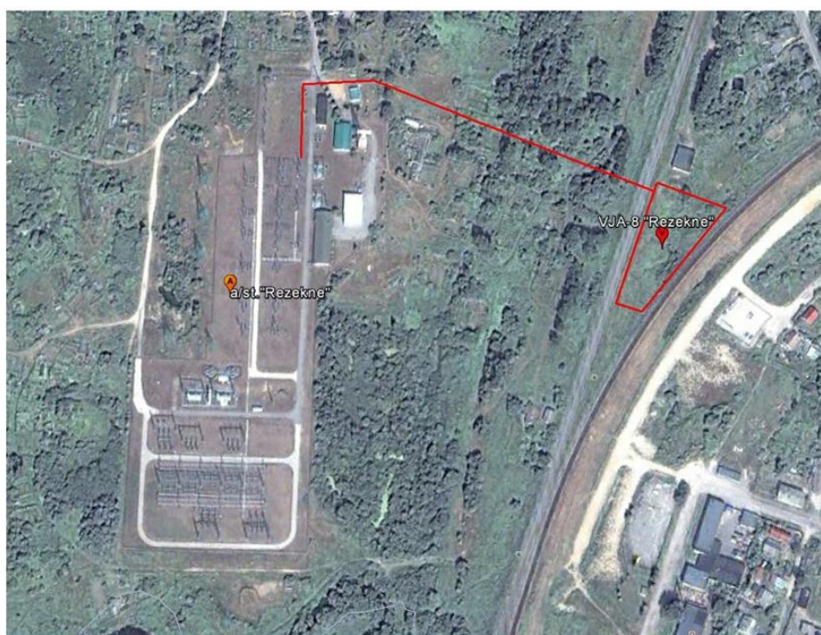
45.attēls VJA-8 Rēzekne pieslēgums pie elektrotīkla
